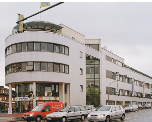
Das Kohake-Center in Garbsen wird mit VRF-Multisplittechnik klimatisiert
