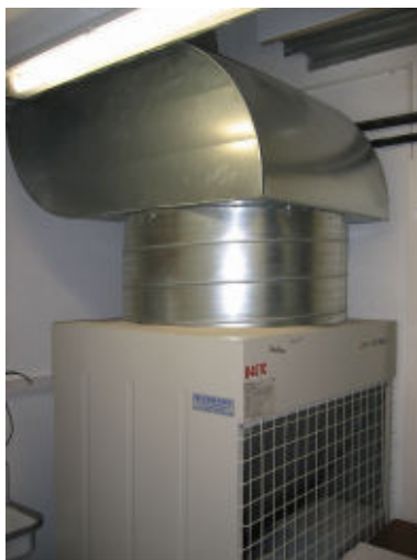
Abb. 2 Die im Verflüssiger des Außengeräts abgegebene Wärme wird über Luftkanäle an die Außenluft abgeführt.
