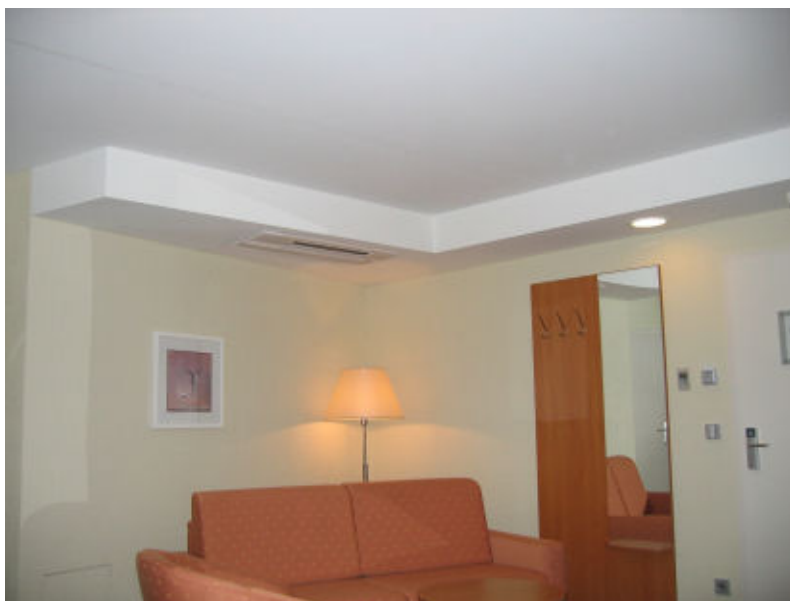
Abb. 3 Installation eines Deckenkassetten-Innengeräts in einem Hotelzimmer.
