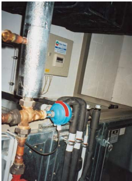
Detail der Verrohrung
