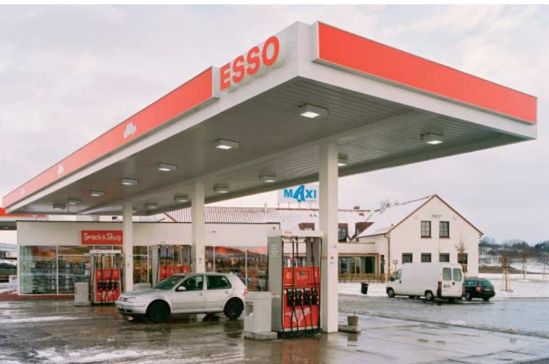
Außenansicht des neuen Autohofes Malsfeld. Hier wurde ein aufwändiges Klimatisierungskonzept für mehrere Zonen realisiert
