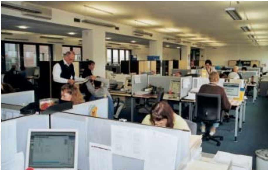
Blick in eines der klimatisierten Großraumbüros
