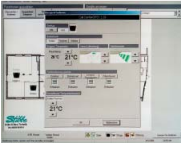
Über eine zentrale Fernbedienung am Empfang lassen sich alle Klimageräte überwachen und regeln
