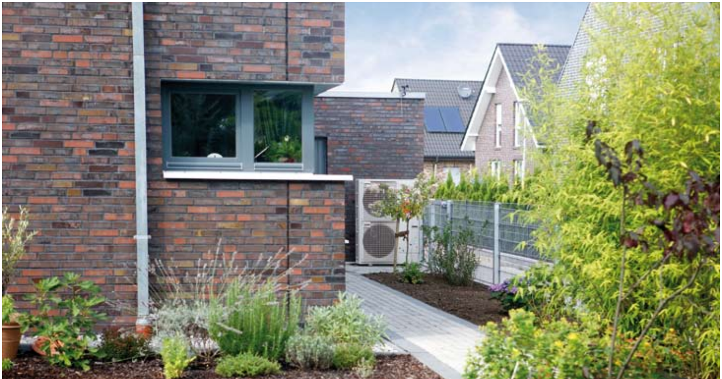
Die installierte Luft-Wasser-Wärmepumpe lief bisher ohne Störungen und auch die Nachbarn fühlten sich nicht durch den Betrieb gestört
