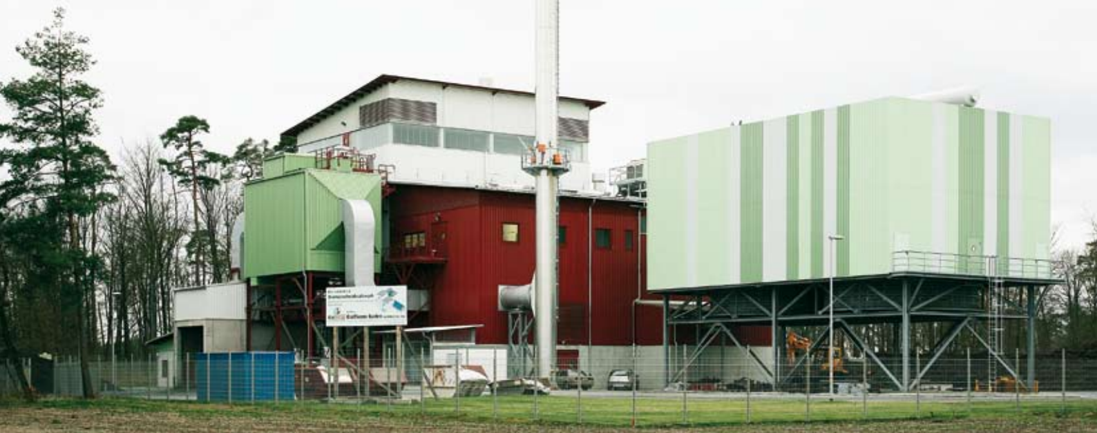
Im Biomasse-Kraftwerk im Baden-Airpark werden pro Jahr 75 000 t Pflanzenbestandteile verfeuert
