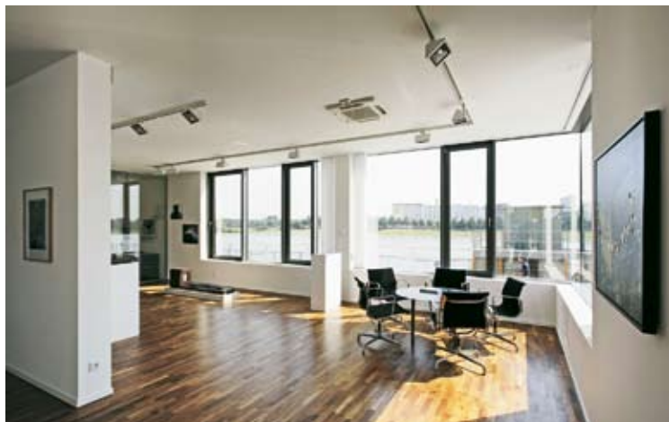
Nicht unsichtbar aber optisch zurückhaltend: Auslässe in Decke und Wand
