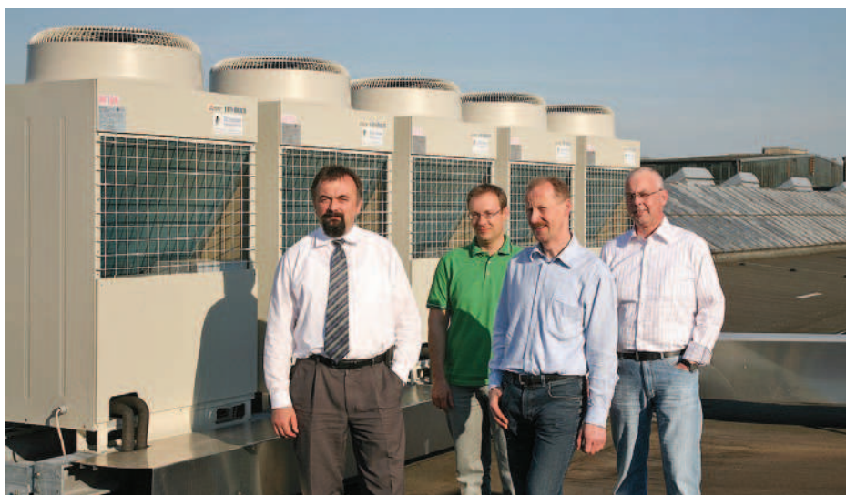
Auf dem Dach vor den fünf Außengeräten (v. l.) Dipl.-Ing. Bernhard Schröter, Leiter Werksdienste ZF Getriebe GmbH, Dipl.-Ing. Rainer Kreschel, Automatisierte Getriebe, ZF Getriebe GmbH, Kälteanlagenbauermeister Jochen Schröder, Schröder Kältetechnik GmbH, und Michael Sperber, Regionalleiter Berlin, Mitsubishi Electric Europe B.V.
